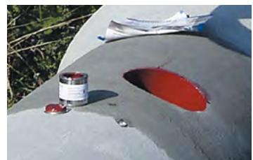
3. Bohrabschlussstutzen zentrisch mit Markierung in Achsenrichtung des Betonrohres bis zum Anschlag in die Bohrung eindrücken. Das zentrische Ansetzen ist wichtig, damit die erste Rippe der Gummimanschette gleichmäßig verpresst wird und nicht umschlägt.
