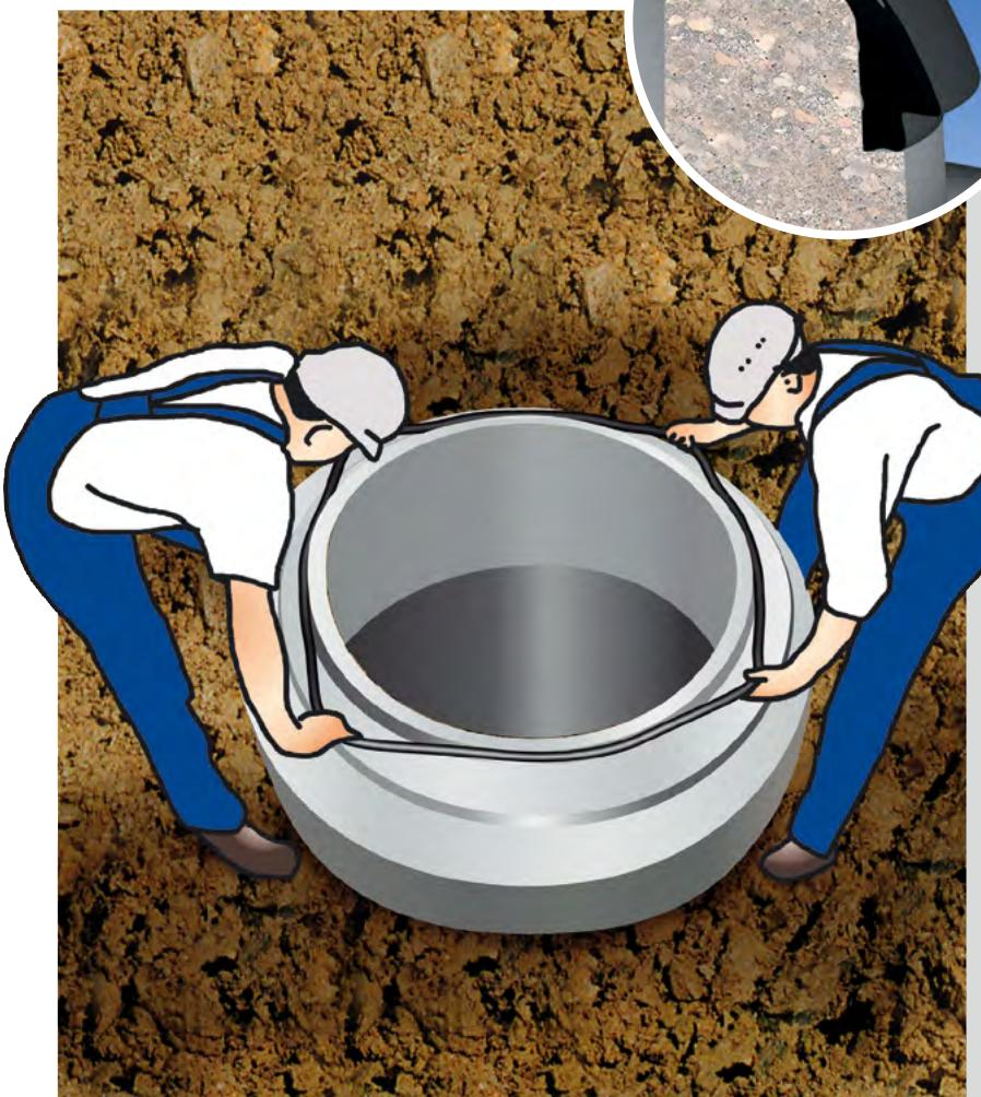
1. Dichtung – Gleitmantel nach oben und außen zeigend – auf das saubere Spitzende aufziehen, Vorspannung durch mehrfaches Ziehen an verschiedenen Stellen gleichmäßig verteilen und auf richtigen Sitz der Dichtung an der Schulter sowie des Lastausgleichs mittig auf dem Spitzende achten.
